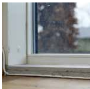
Niveauforskellen for dørtrinnet. Denne er for høj for kørestols- og rollatorbrugere og ville derfor kræve en sliske eller anden løsning.
