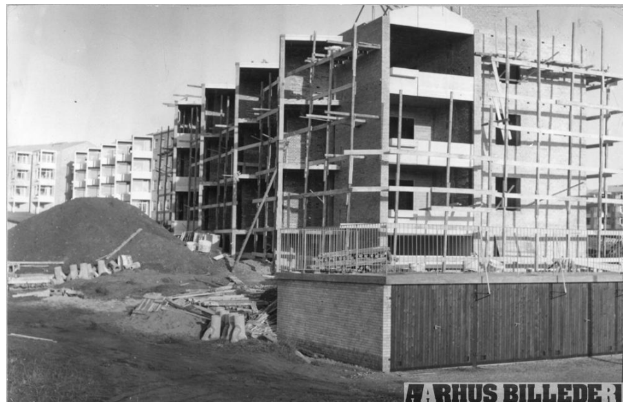
Søvangen under opførelse 1955
