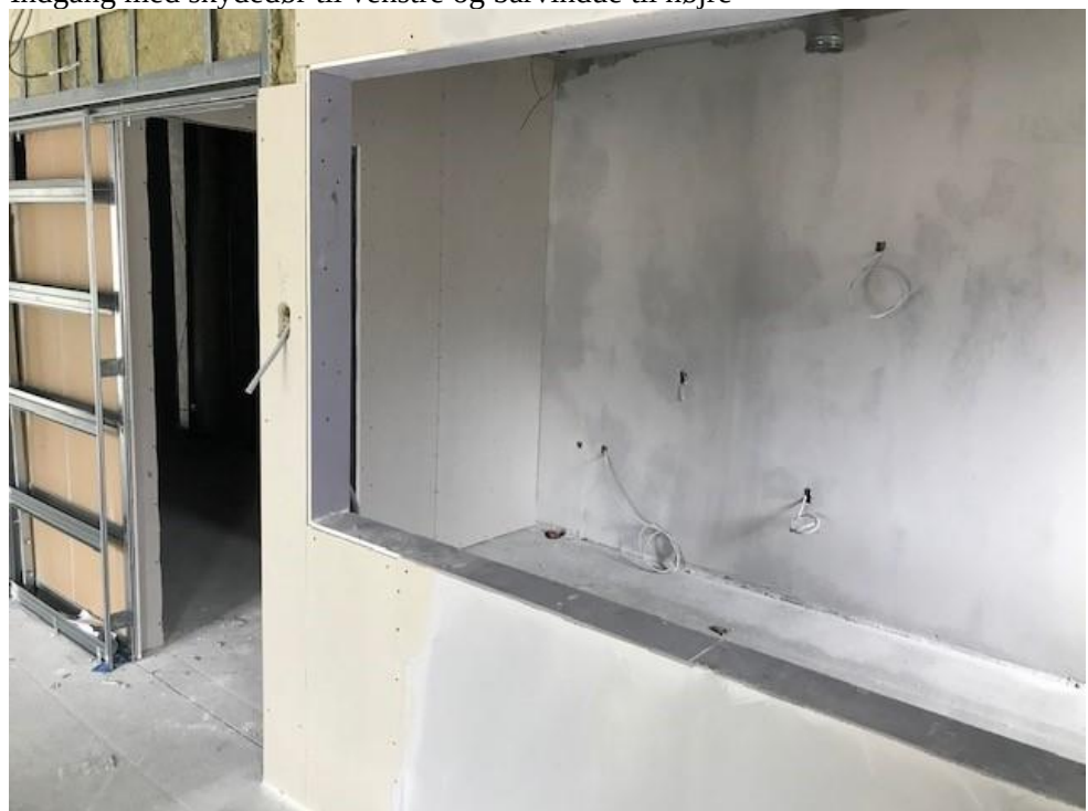
Bagved til venstre kan man se indgangen til et tilstødende lokale, hvor opvask mv. kan foregå
