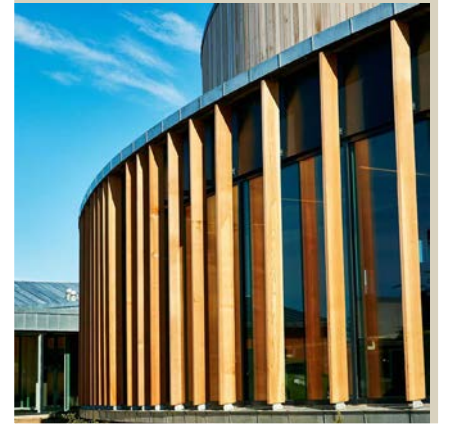
Gennemgående lodrette lameller påsat vinduesparti
