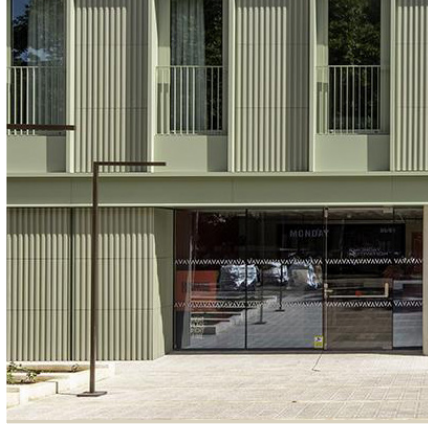
Vinduespartier og profileret alu-beklædning i basen
