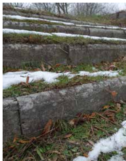
Betonstenene, der danner forkant på de græsklædte tilskuerpladser omkring cyklebanen, er afrundet i toppen.
