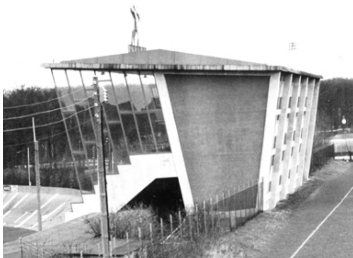
Gavl mod vest - 1954 Bemærk den skrå afslutning af gavlens lukkede del og de tre åbninger nederst. 1:300.
