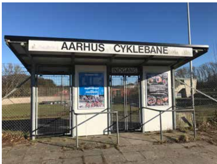
Publikumsindgangen til cyklebanen er en simpel konstruktion udført i galvaniserede stålrør og hvide plader. Indgangen indgår som end del af hegnet omkring cyklebanen.
