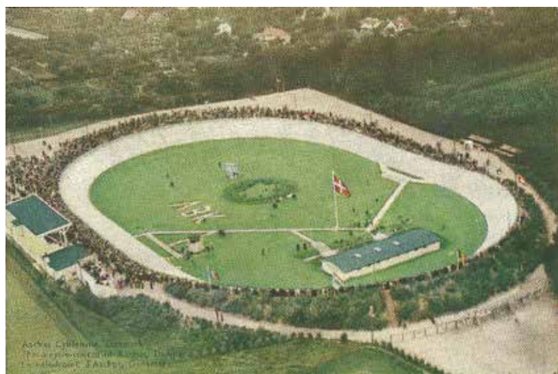
Luftfoto af cyklebanen umiddelbart efter opførelsen, med indgang fra øst. Cyklebanen ligger som en integreret del af landskabet.
