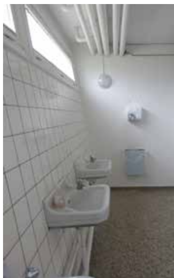
Øverst TH: Herretoilettet med nytilkomne pissoir. Bemærk at der ikke er vinduer i facaden, da toilettet ligger ud for den lukkede bagfacade.
