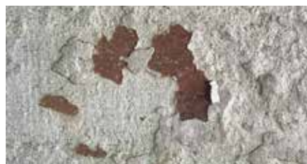
TH: Detaljebillede af den lukkede del af gavl, der tydeligt viser, at det tilbagetrukket felt oprindeligt var rødbrunt.
