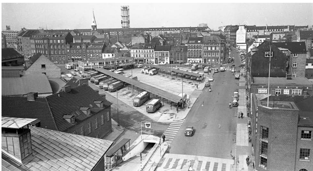
Rutebilstationen set fra badeanstaltens tårn, ca. 1955. Bemærk nedkørslen til parkeringskælderen.
