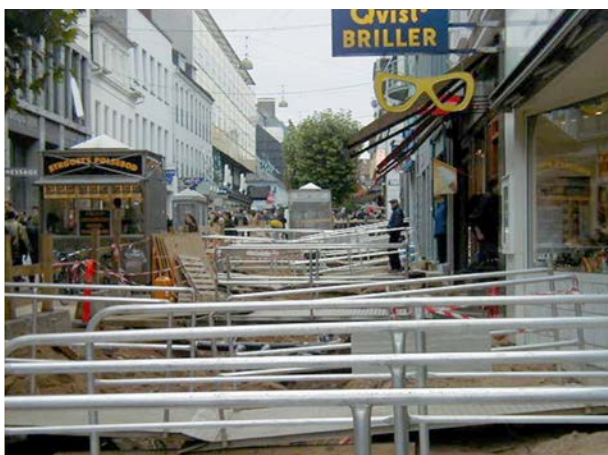
Det var en logistisk øvelse at få skred i anlægsarbejdet og samtidig sikre kundernes adgang til butikkerne, 2001. Foto: Forfatteren.
