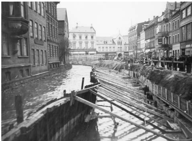
Overdækning omkring 1933. Bemærk den høje vandstand, der presser skillevæggen. Foto: Stadsingeniørens Kontor, Aarhus Stadsarkiv.
