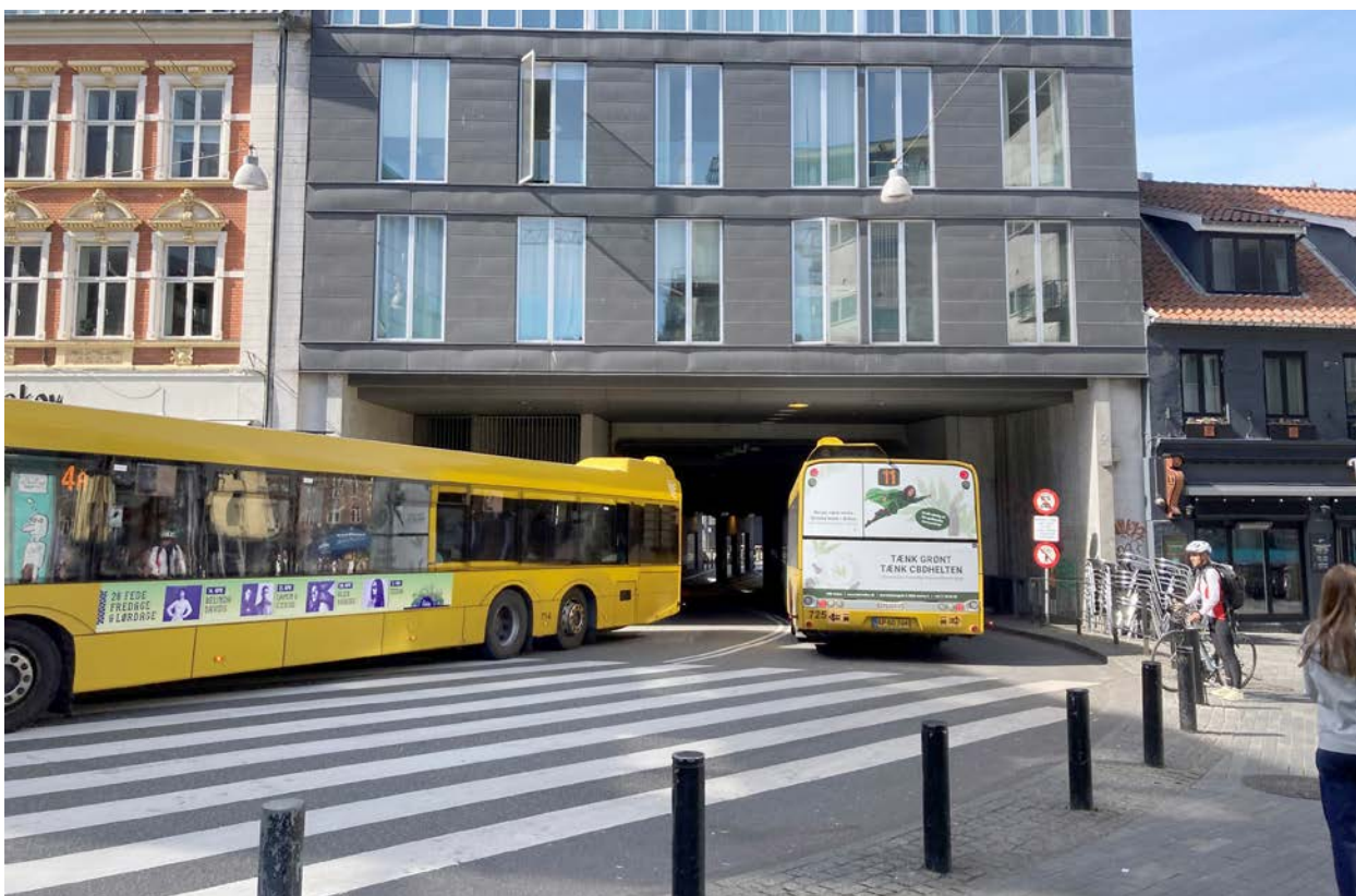
Busgaden set fra Frederiksgade, 2022. Foto: Forfatteren.
