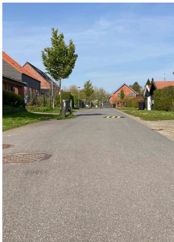
Villavej i Beder. Selvom vejen er født snæver og med forskydninger, har det alligevel været nødvendigt at supplere med ekstra vej bump, 2024.
