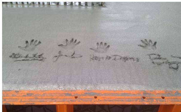
I stedet for første spadestik blev der arrangeret kickoff med blandt andet håndaftryk i fundamentet for broen over Egådalen, 2013.
