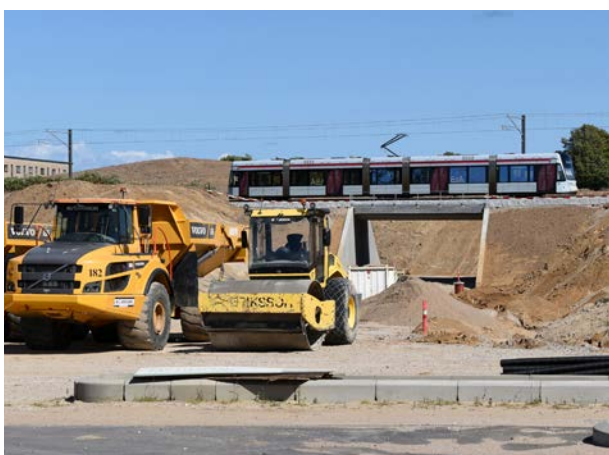
På en uge i juli 2022 blev der gravet igennem, broen blev skubbet på plads, og letbanen kunne køre igen, 2022. Foto: Forfatteren.
