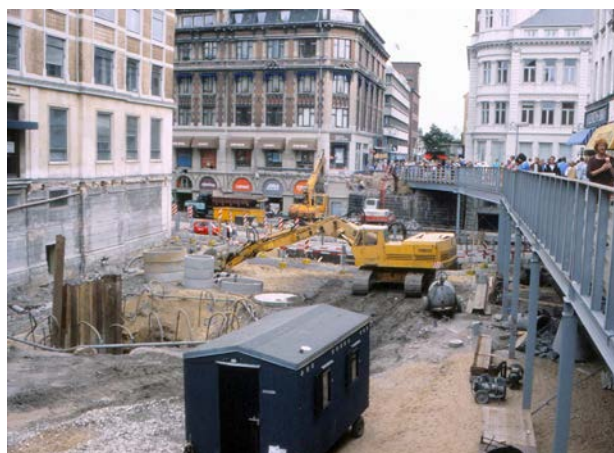
Midlertidig gangbro under arbejdet med den nye Skt. Clemens Bro, 1983.
