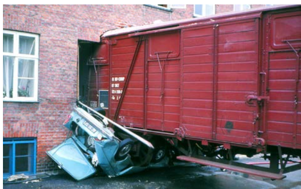
Rangeruheld i Skovgaardsgade, 1972. Godsvognen har ramt nr. 4. Omridset af hullet kan stadig ses i det opmurede parti ved dør og vindue.
