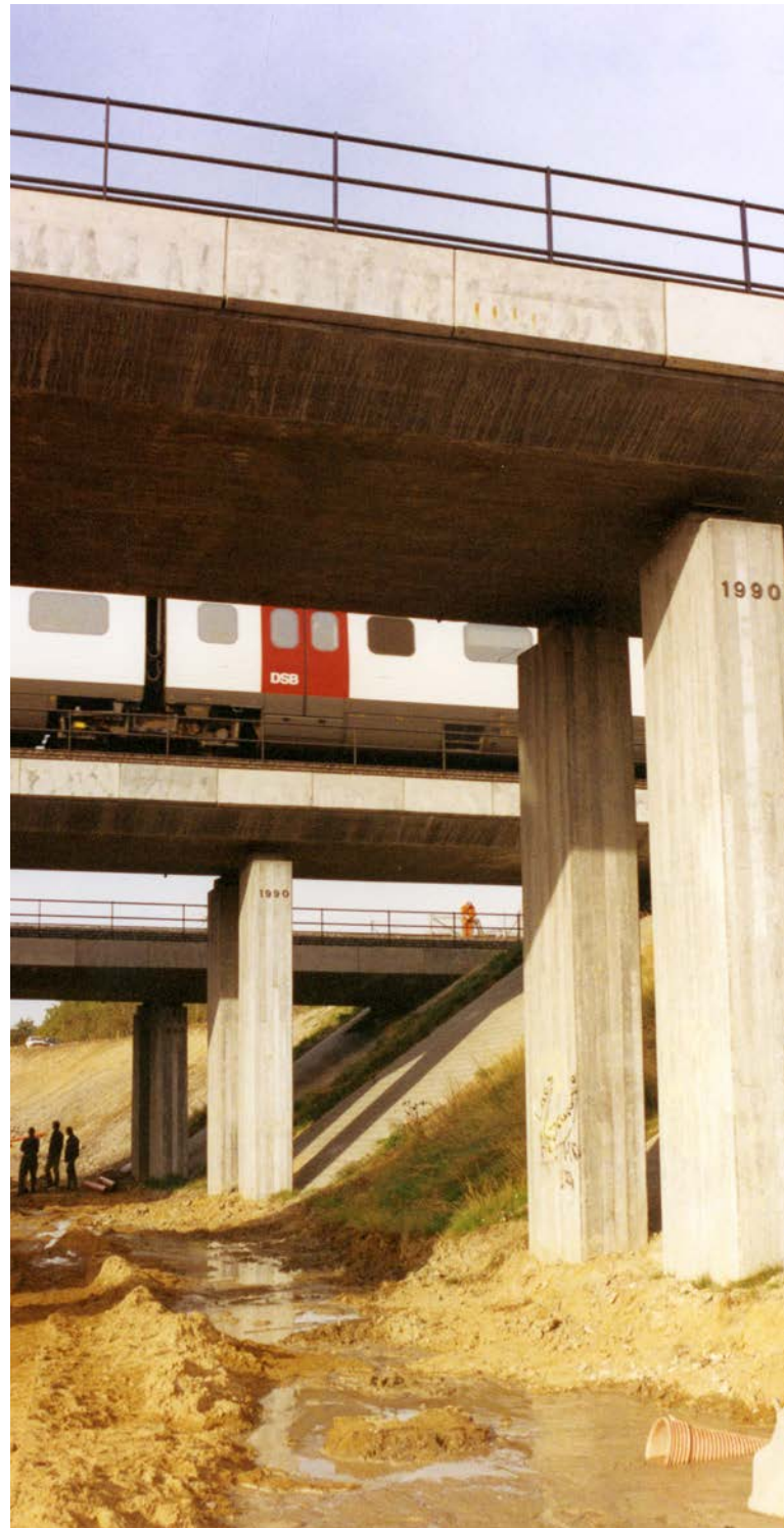
Ringvej Syd under anlæg ved jernbanebroerne, 1990.
