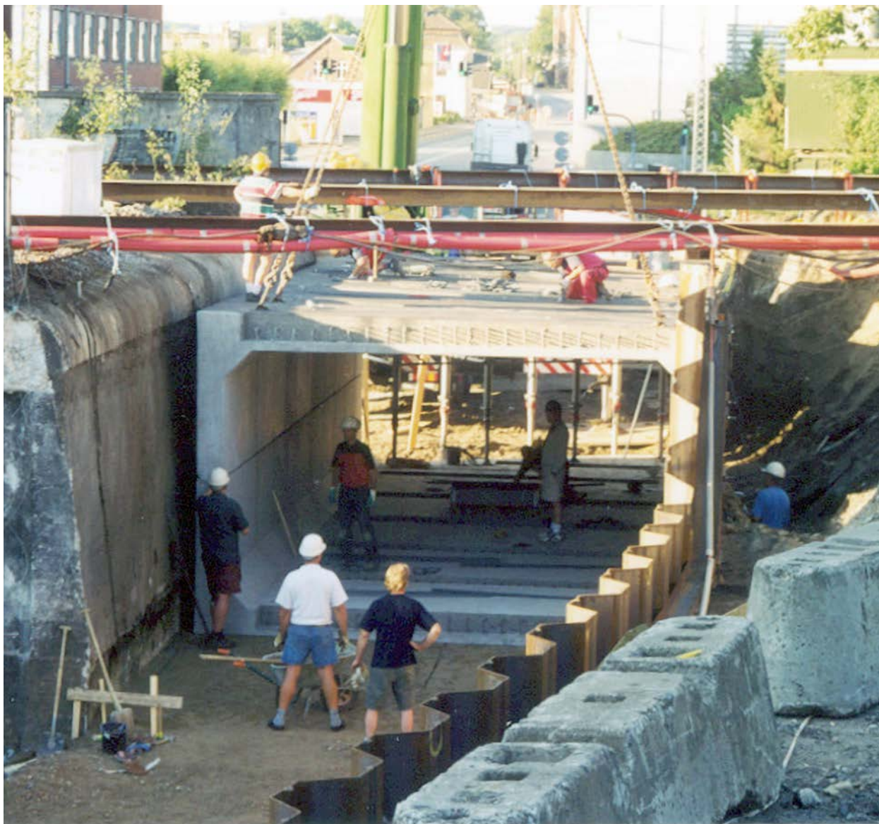
Nyt tunnelelement sættes ind under Grenaabanen, august 2003.
