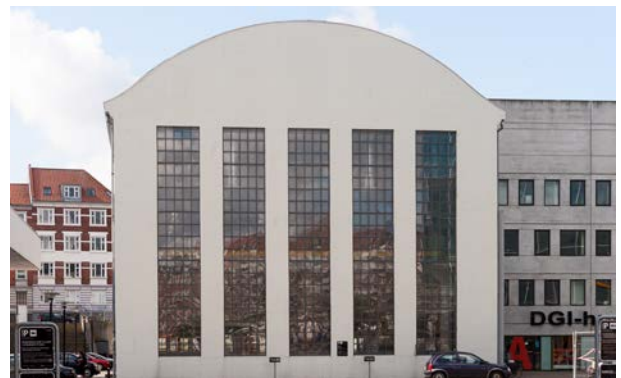
Gavlen af det bevarede lokomotivværksted, 2015.
