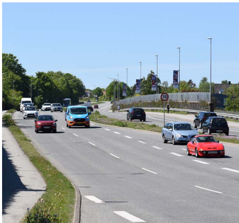
Grenåvej på vejbro over Grenaabanen, set fra Hørgårdsvej mod Vejlbj Bakke, 2024.
