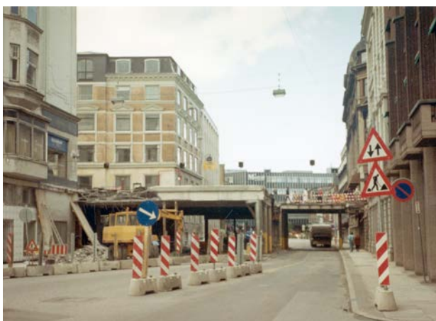
Skt. Clemens Bro under nedbrydning, 1984.
