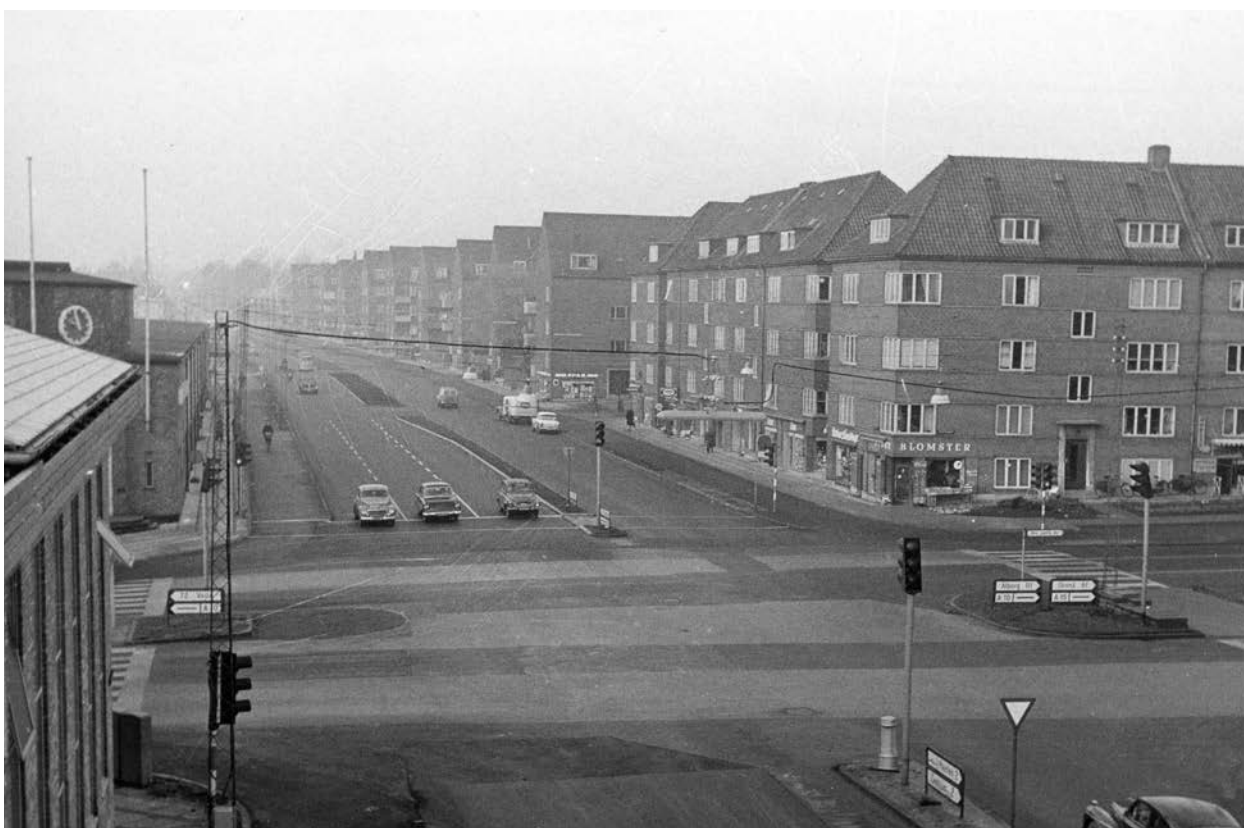
Silkeborgvej 92-94, Bygningen er rullet fire meter tilbage og Silkeborgvej er udvidet, 1962.
