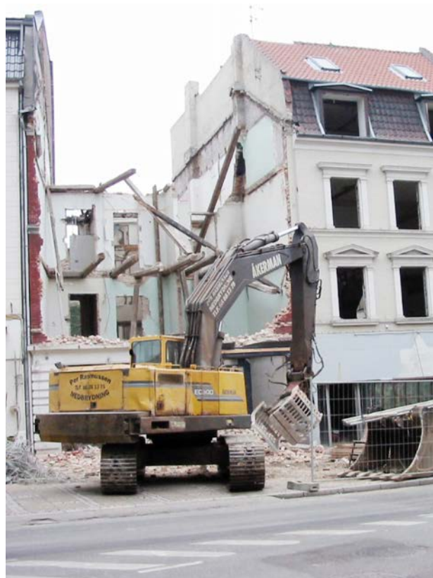
Nedbrydning af Frederiksgade 18C, marts 2003. Foto: Forfatteren.
