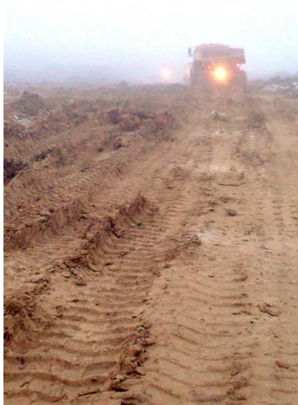
Kalkstabilisering en diset januar morgen, 2009. Foto: Trafik og Veje.
