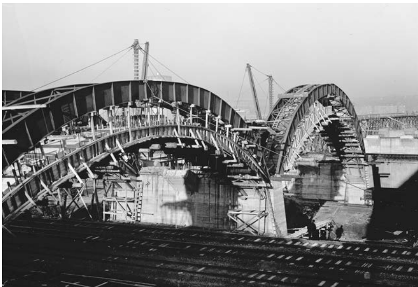
Forskalling til støbning af betonbuerne, 1937.
