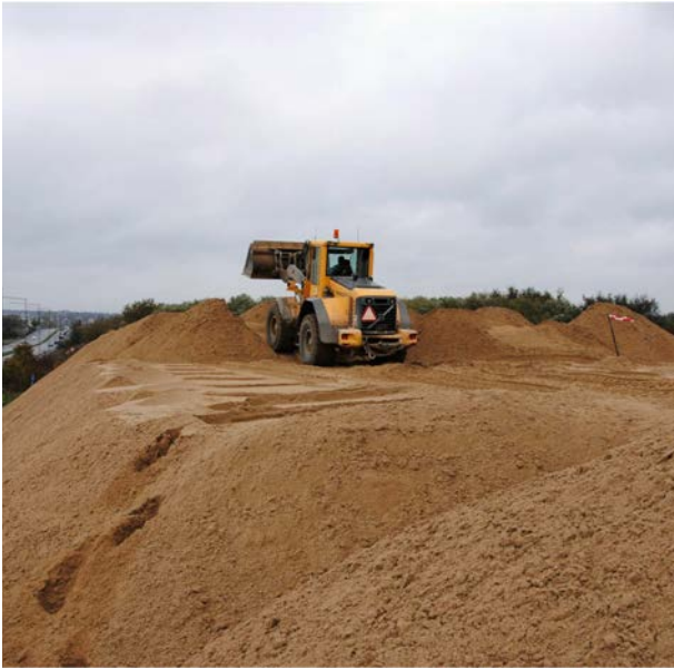
Sandbunken, der skulle komprimere den underliggende jord i den nye Åhavevejs linjeføring, 2011.
