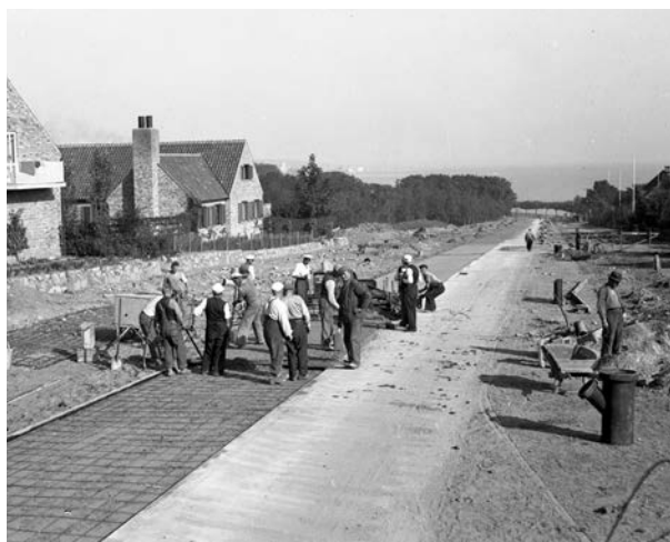
Oddervej, kørebaner støbes i beton, ca. 1936. Foto: Aage Fredslund Andersen, Aarhus Stadsarkiv.
