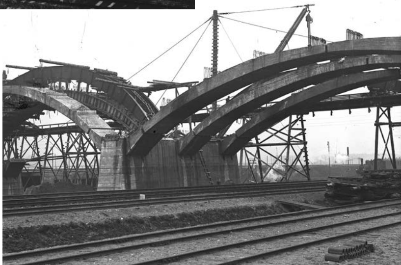
De færdige betonbuer, bagved ses den midlertidige arbejdsbro, 1937.
