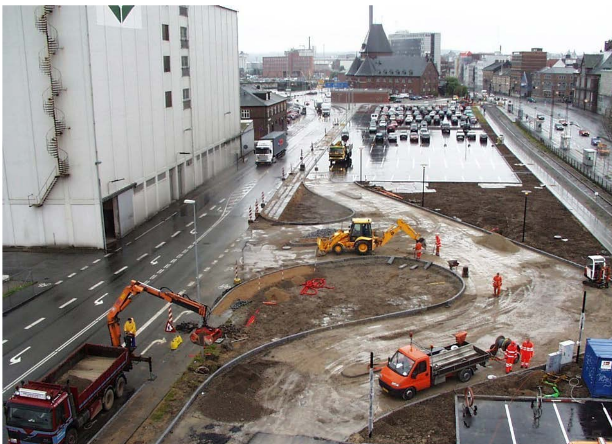
P-politik rulles ud. Et ryddet areal mellem Nordhavns-gade og Grenaabanen blev omlagt til midlertidig p-plads. De nu nedrevne bygninger, KFK-siloen og Pakhus 27 ses til venstre. P-pladserne er siden erstattet af de store p-anlæg under Navitas og Dokk1, 2002.
