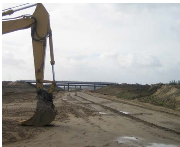
Motorvejen under anlæg, set mod vest mod broerne til den store rundkørsel ved Lystrup, 2006.
