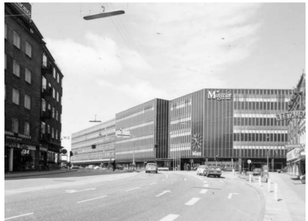
Overdækket 1975. Foto: Stadsarkitektens Kontor, Aarhus Stadsarkiv.
