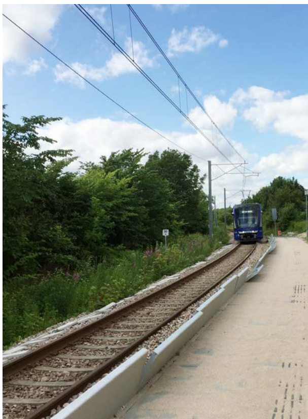
Perronforkanter, der kan klappes op, under konstruktion på Beder Station, 2017.
