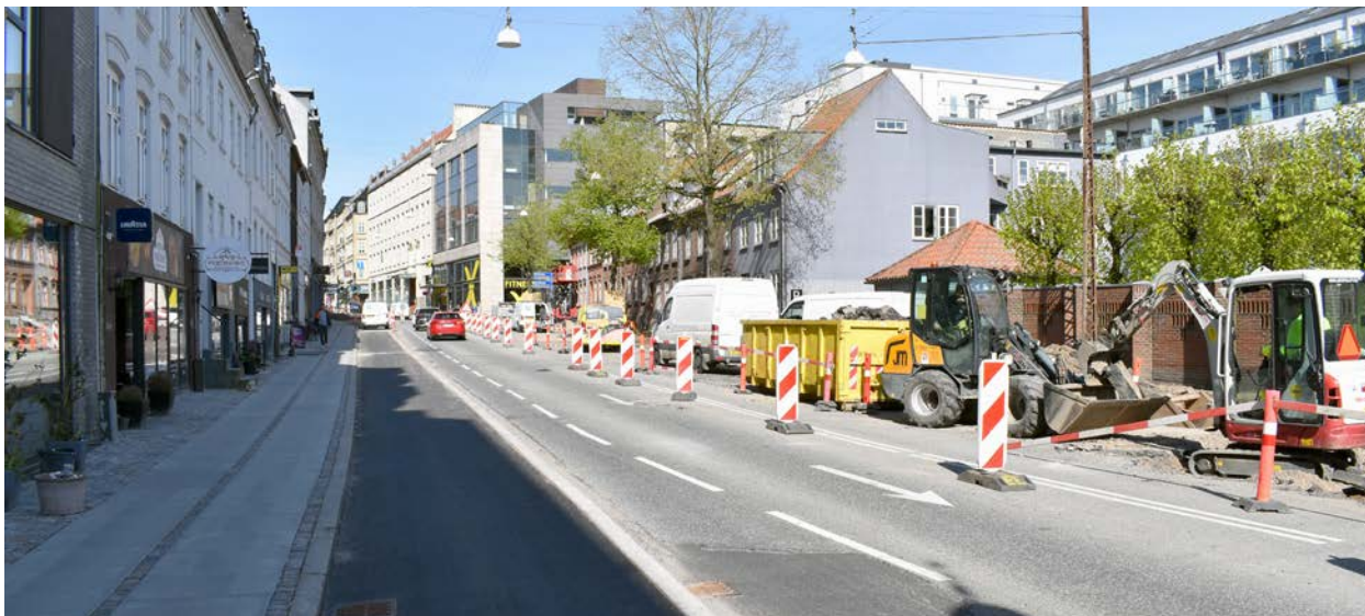
Mobilitetsplan under realisering. Cykelstier under anlæg på Sønder Allé. Set mod vest mod Amaliegade, 2024. Foto: Forfatteren.
