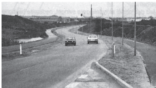
Ringvej Syd set mod øst fra Bjødstrupvej, 1984. Foto: Aarhus Kommunes beretning 1984.
