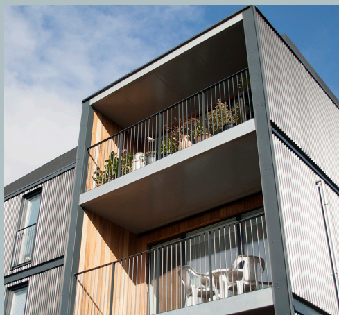
Beboelsesejendomme på Trige Parkvej fra 1980 er blevet gennemrenoverede, så de nu er moderne og energieffektive boliger med nye installationer. Bebyggelsen omfatter 13.000 m 2 .
