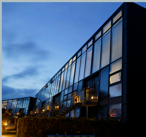
Økohuset på Skejbytoften, et økologisk forsøgsbyggeri på 3.400 m 2 med mange bæredygtige tiltag. Det er opført i 1998.
