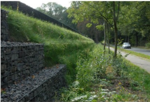
Eksempel på terrasseret jordvold udført med gabioner
