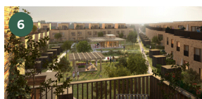
HAVEHUSENE Kuben Management A/S Ca. 34 andelsboliger 5 ejerboligere Byggeri pågår Indflytningsklar september 2023
