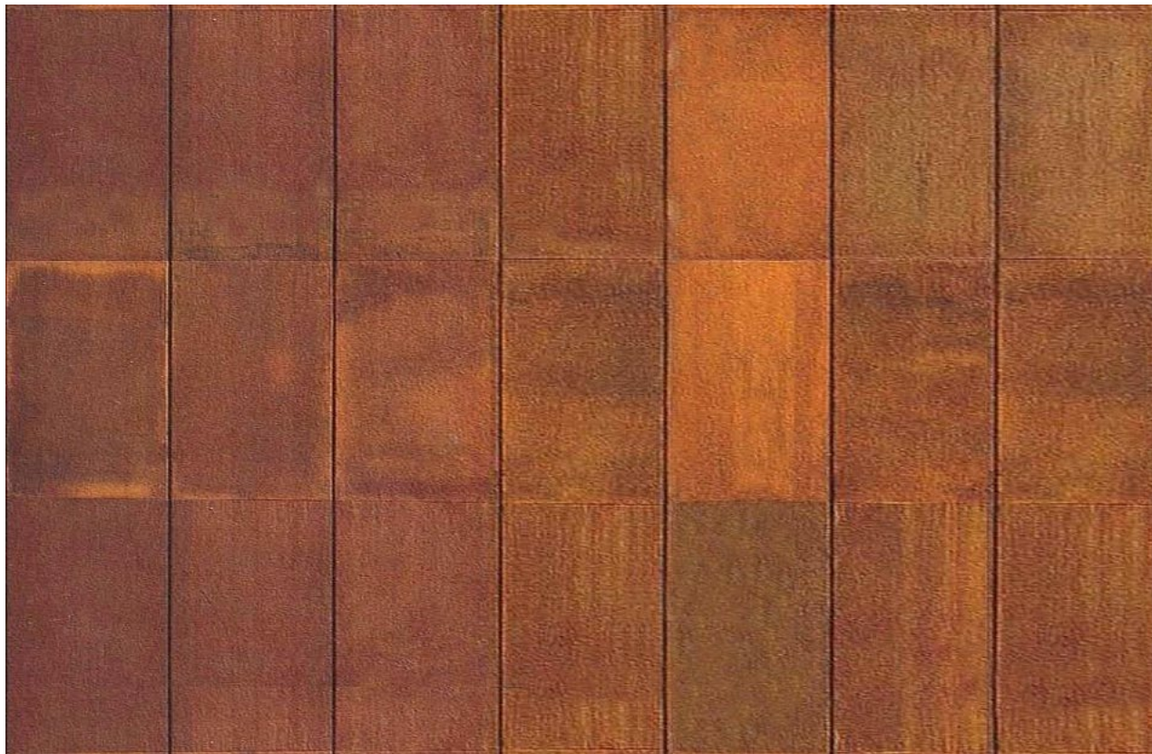
De nye facader laves i plader af cortenstål, som spiller sammen med de røde nuancer fra eksisterende facader
